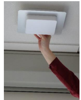
Figure 2: Placez le spot sur le plafond
